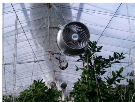
写真 ハウスみかん施設に導入された被覆(内張)の多層化及び循環扇
