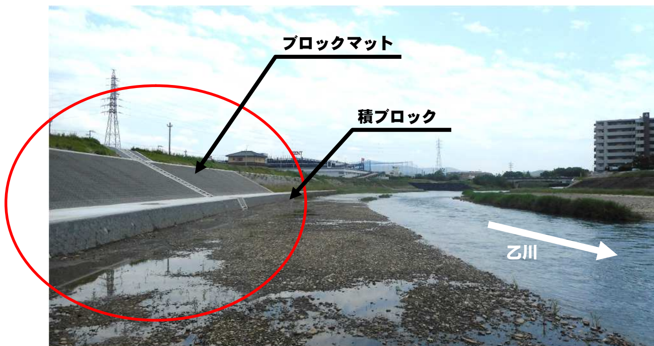
2022年度に実施した護岸工事現場（通常製品を使用）
