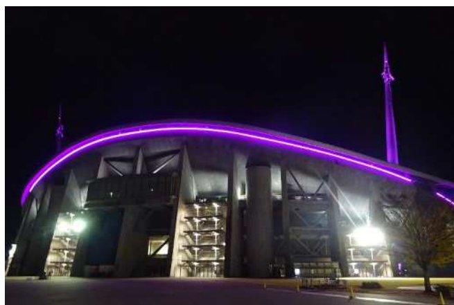
▲豊田スタジアムライトアップの様子
