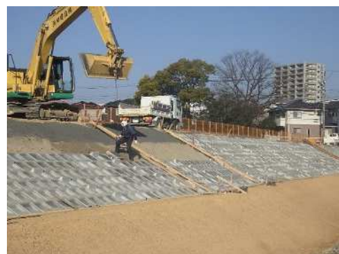
堤体の整備工事の状況(池の内側) (老朽ため池等整備事業 本地新池地区)
