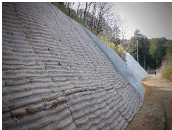
改良工事による法面保護
