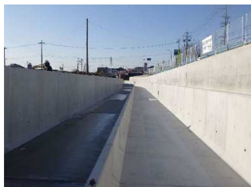
耐震化工事を実施した枝下用水幹線水路 (枝下用水2期地区)
