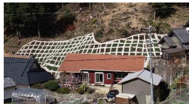
人家裏の山腹に施工した法枠工
