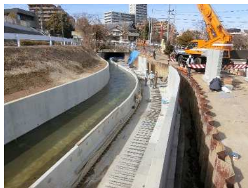
改修工事中の枝下用水幹線水路 (枝下用水地区)
