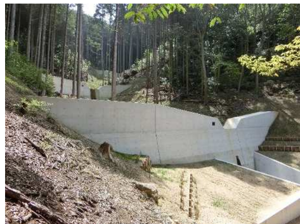
荒廃溪流に設置した治山ダム
