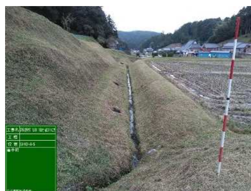
工事前の排水路 （下山地区）
