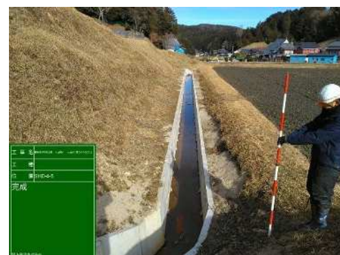
工事により排水能力が向上した排水路 （下山地区）
