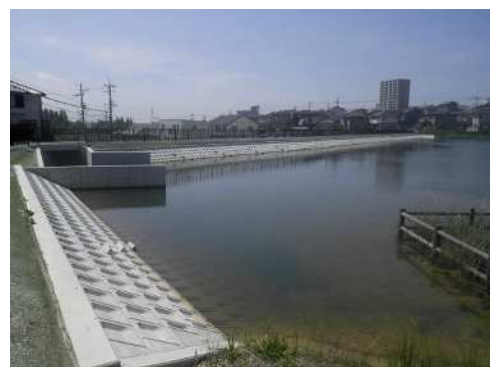
工事が完了した堤体 (老朽ため池等整備事業 本地新池地区)
