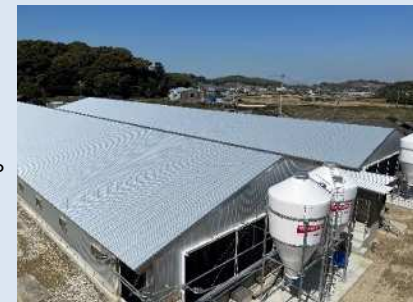
クラスター事業で整備した畜舎
