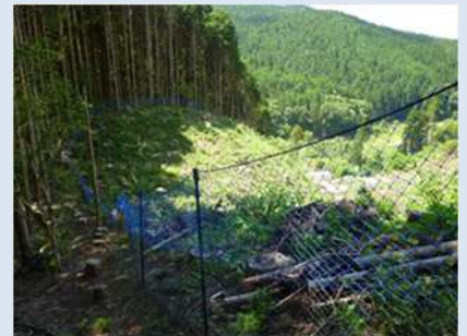
主伐後の植栽地における獣害防止柵の設置
