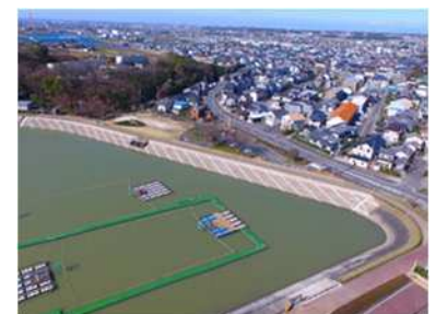
ため池の耐震対策
