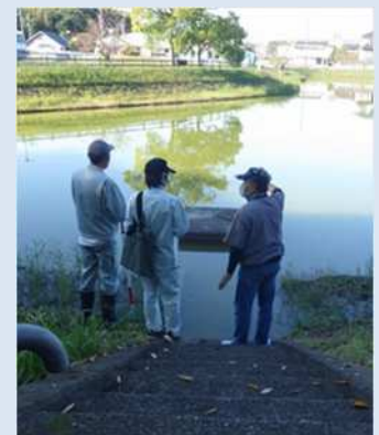
ため池の現地パトロール
