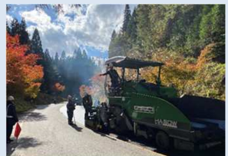
農道の整備（設楽町）
