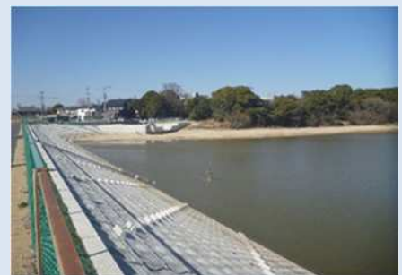
農業用ため池の整備（刈谷市）
