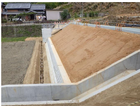
取水兼緊急放流施設・洪水吐の整備 (新城市松葉池地区)
