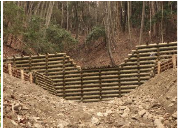
木製校倉式治山ダム（豊根村）
