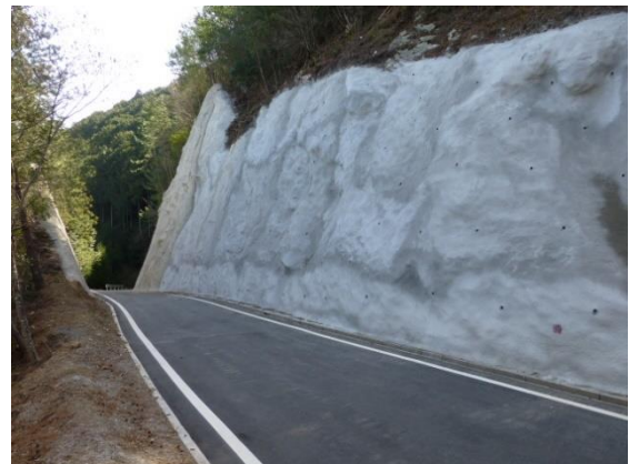
林道改良事業（改良） 塩瀬本線（新城市）
