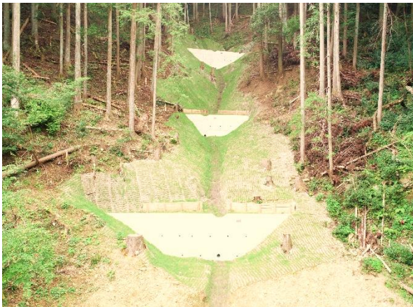
土留工（東栄町）
