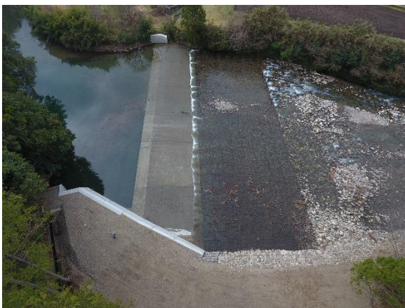
取水堰の整備（新城市布里地区）
