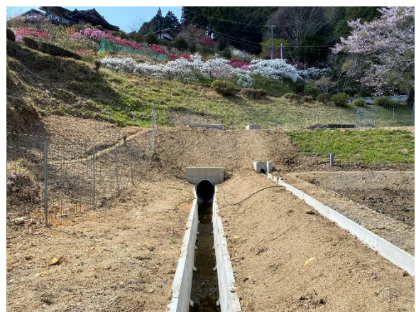
水路の整備（設楽町田峯地区）
