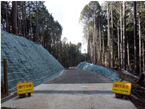
過疎山村地域代行林道事業 中口尤線 3 工区工事（設楽町）
