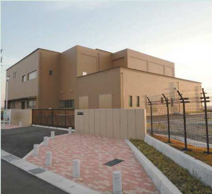
弥富ポンプ場
