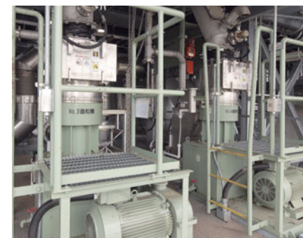
③造粒機(押出成型式) 粉塵抑制のため乾燥污泥をφ約5~6mm、長さ約10~15mmに成型します。
