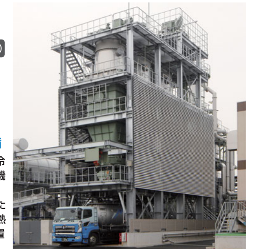
⑦炭化物ホッパ(20m×3基) 下水污泥炭化燃料(炭化物)を一時貯留します。
