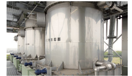
⑥炭化物冷却器(多管式間接冷却) 下水污泥炭化燃料(炭化物)を45℃以下まで間接冷却し安定化させます。
