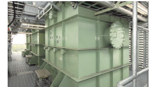
⑦炭化物ホッパ(20m×3基) 下水污泥炭化燃料(炭化物)を一時貯留します。
