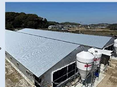
クラスター事業で整備した畜舎
