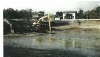
＜ため池の浚渫工事＞
