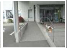
出入口の段差解消 事業費：30万円程度
