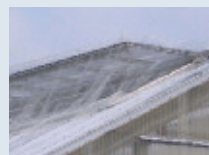
開口部(天窓)へのネットの設置
