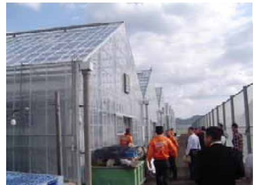
写真2 硬質プラスチックハウス（右は風による火山性の小石の吹きつけを防ぐネット）
