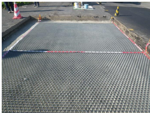
【（主）名古屋碧南線・浜町橋】
