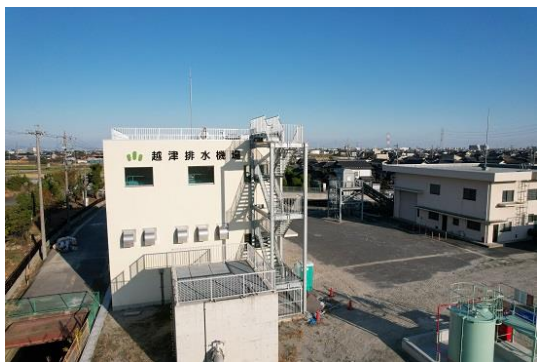
【整備完了状況】
