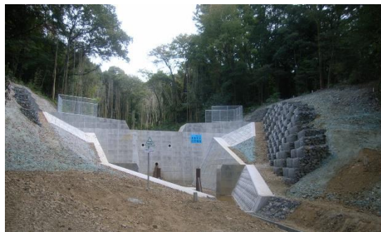
【砂防堰堤の整備（犬山市）】
