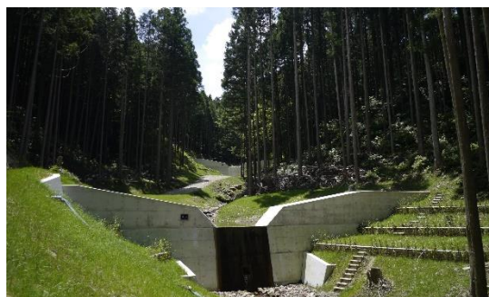
【治山施設の整備（豊田市）】
