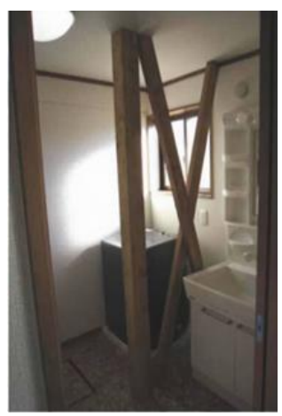
【戸建住宅の耐震改修】
