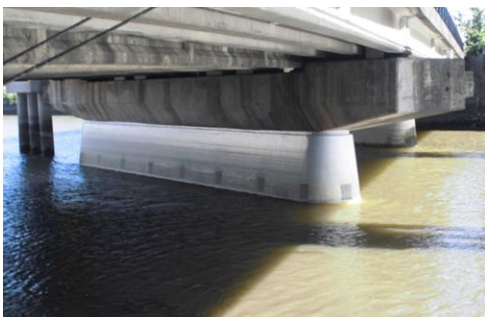
【(一) 碧南半田常滑線・東雲橋】
