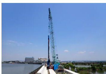
【日光川 鋼矢板打設状況】 【豊橋海岸 鋼矢板打設状況】
