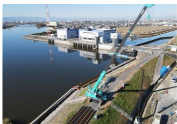
【日光川 鋼矢板打設状況】 【豊橋海岸 鋼矢板打設状況】
