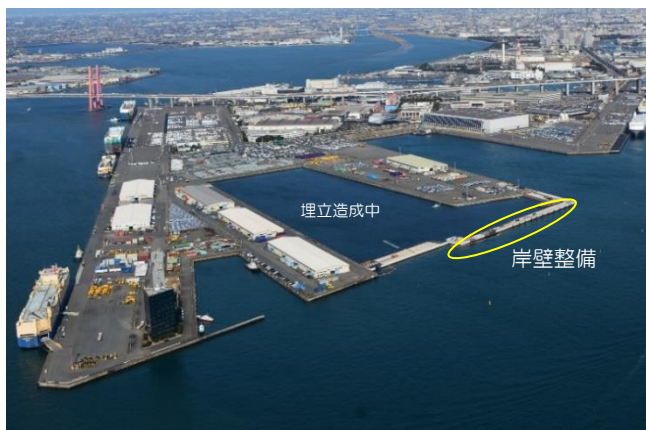
【金城ふ頭の耐震強化岸壁】
