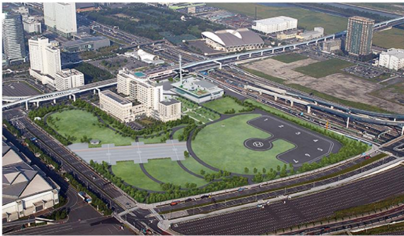
東京臨海広域防災公園HPより
