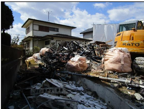
【解体工事現場の様子】
