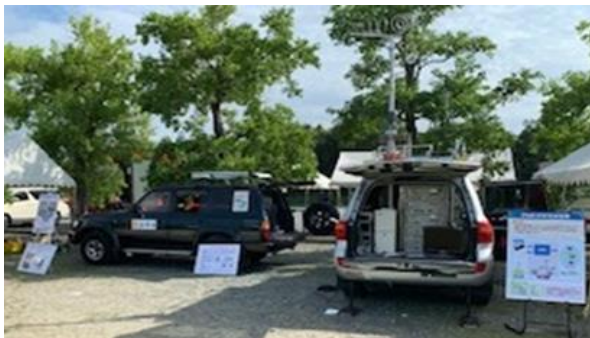
【電源車から送信車両への給電】
