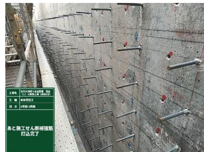
【処理場施設の耐震化】 矢作川浄化センター (西尾市)
