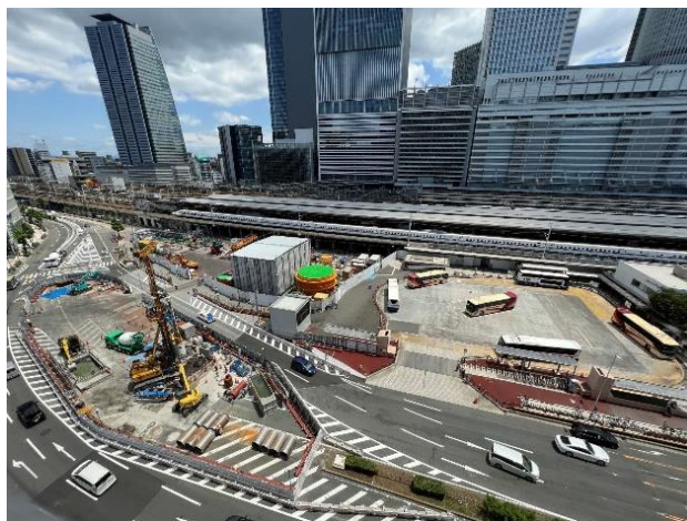
【 名古屋駅（中央西工区） 】
