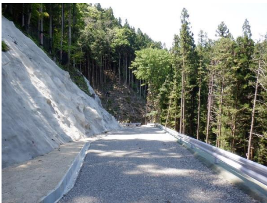
【林道開設状況】
