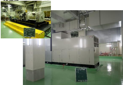
【非常用自家発電設備の整備】 日光川下流域下水道 弥富ポンプ場 (弥富市)
