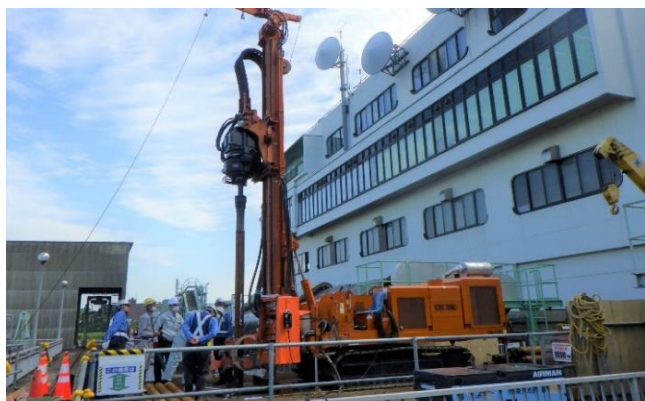
【排水機場の基礎の耐震化】
