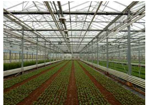
フェンロー温室内部。電照効果に加え生育促進効果のある高圧ナトリウムランプをオランダから輸入し、設置している。
