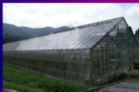
写真3 ハウスの様子
