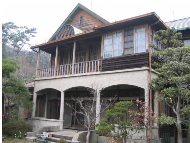
久野家住宅（愛山居）主屋（東海市提供）
