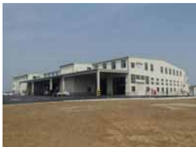
集出荷施設全景
