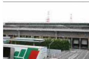
市場棟の外観
