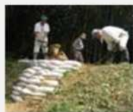
漏水箇所の補修
