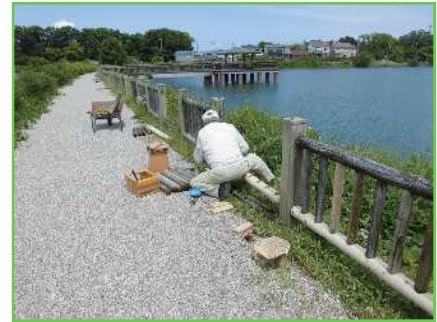
ため池木柵補修
