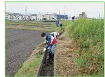
水路の泥上げ
