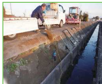
水路の補修（直営施工）
