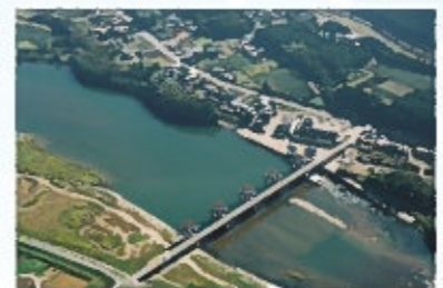
牟呂松原頭首工
