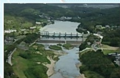
明治用水頭首工
