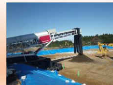
中間貯蔵施設 土壌貯蔵施設
