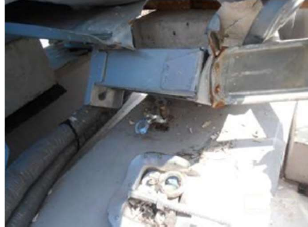
脚部損傷の例
