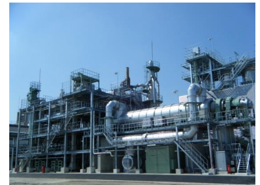
衣浦東部浄化センター燃料化施設
