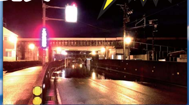
冠水したアンダーパス
