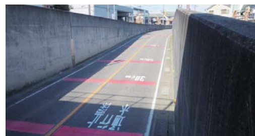
水深を示す路面標示の設置
