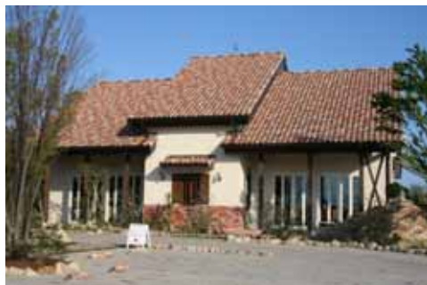
ココテラスの外観 (伊勢湾が臨める高台に建っている)
