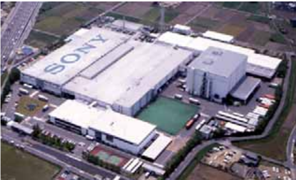
【写真1】 一宮テック 全景
