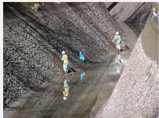
導水路での削ぎ落とし作業
