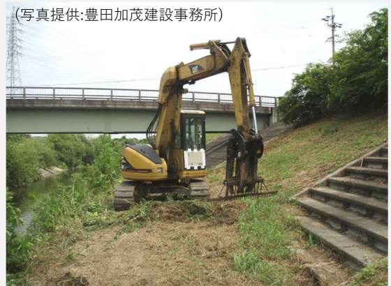
重機による除去作業
