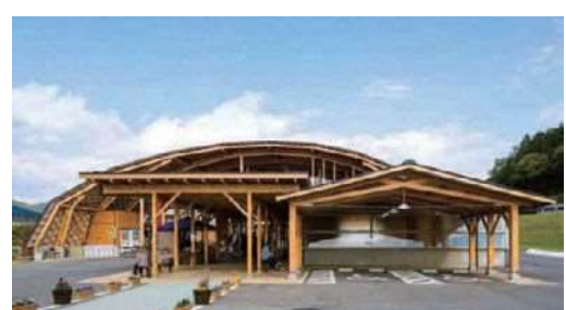
道の駅 もっくる新城 所在地：新城市 主要用途：道の駅
