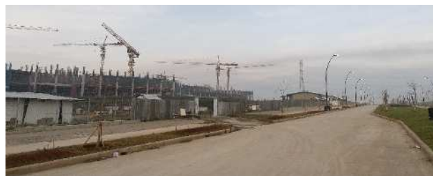
図 5 建設が進むデルタマス・シティのイオンモール
