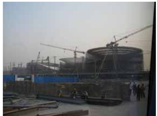
建設が進む万博会場
