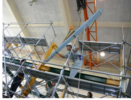
鉄骨建築の建て方
