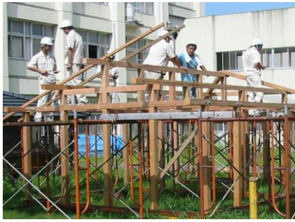
木造建築の建て方
