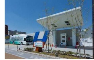
とよたエコフルタウン水素ステーション
