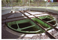
旧武豊港駅転車台
