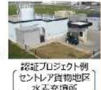
認証プロジェクト例 セントレア食物地区 水素充填所
