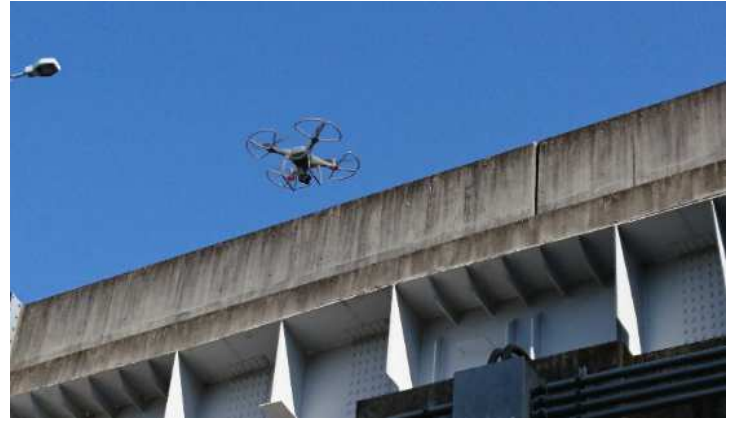
(ドローンを用いた橋梁点検 (実証実験の様子))
