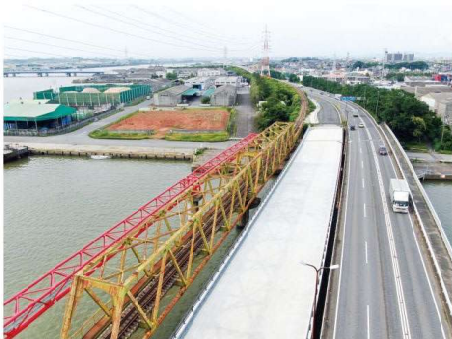
(国)247号 碧南高浜拡幅(碧南市、高浜市)
