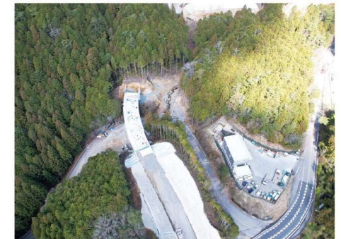
(国)257号 清崎工区(設楽町)
