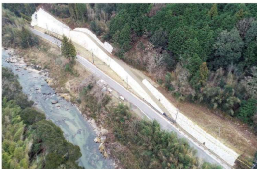
(主)岡崎足助線 鍋田工区(豊田市)
