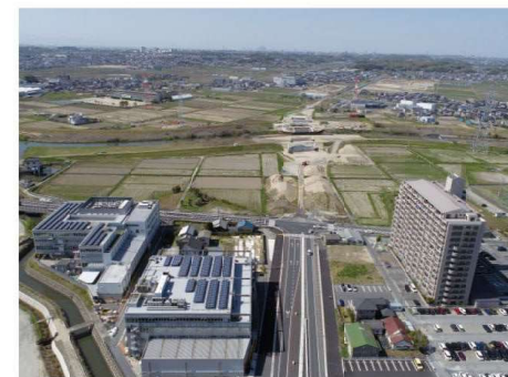
(主)名古屋岡崎線 豊明刈谷工区(豊明市・刈谷市)
