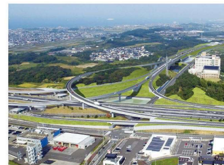
西知多道路 常滑JCT(仮称)(常滑市)
