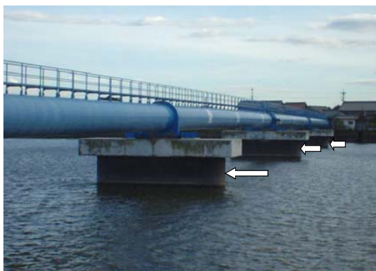
基礎の補強事例(筏川第2水管橋)
