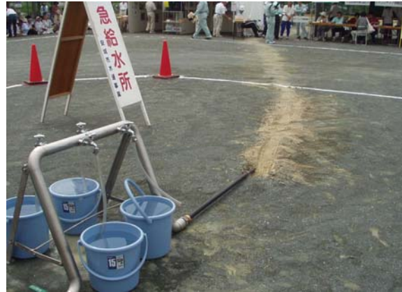
写真2 仮設給水栓による応急給水状況
