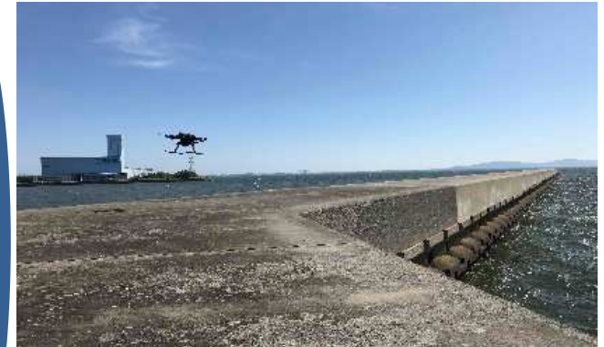
港湾施設の 定期点検
