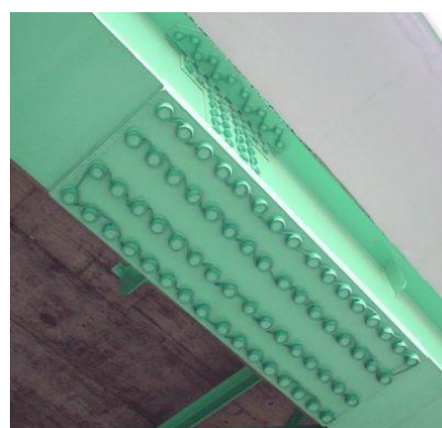
写真 1.6.2 ボルトキャップで連結する方法
