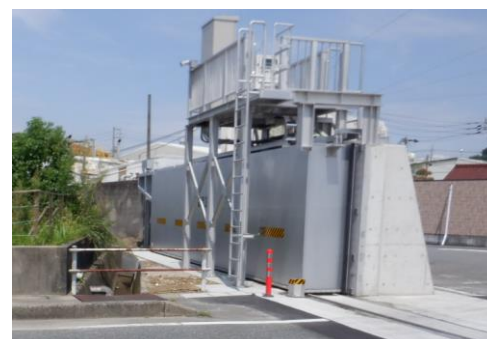
陸閘の改築 【衣浦港海岸高浜地区】
