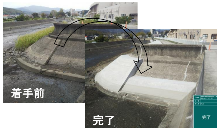
老朽化した堤防の補修 【蒲郡海岸鹿島地区(2018~2024実施)】
