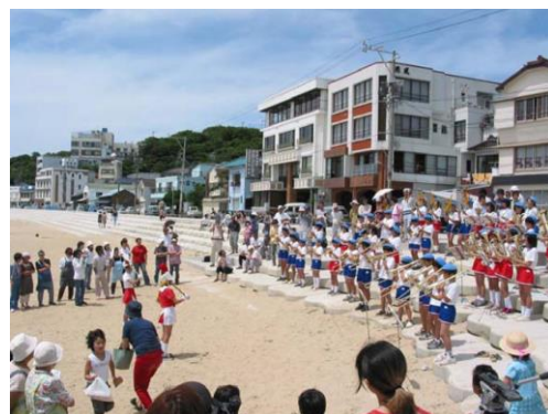
緩傾斜ブロックの利用状況 【師崎海岸篠島地区】
