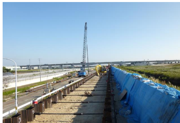
堤防の耐震化 【海部海岸(弥富市)】
