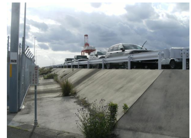
モータープール嵩上げ 【三河港神野西地区】
