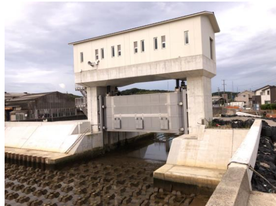
水門の改築(耐震化、自動閉鎖化) 【美浜海岸布土川樋門(美浜町)】
