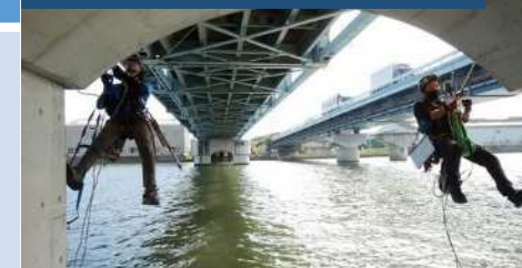
(国)247号 衣浦大橋(半田市)
