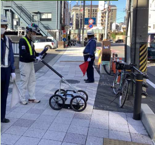
地中レーダー探査の様子
