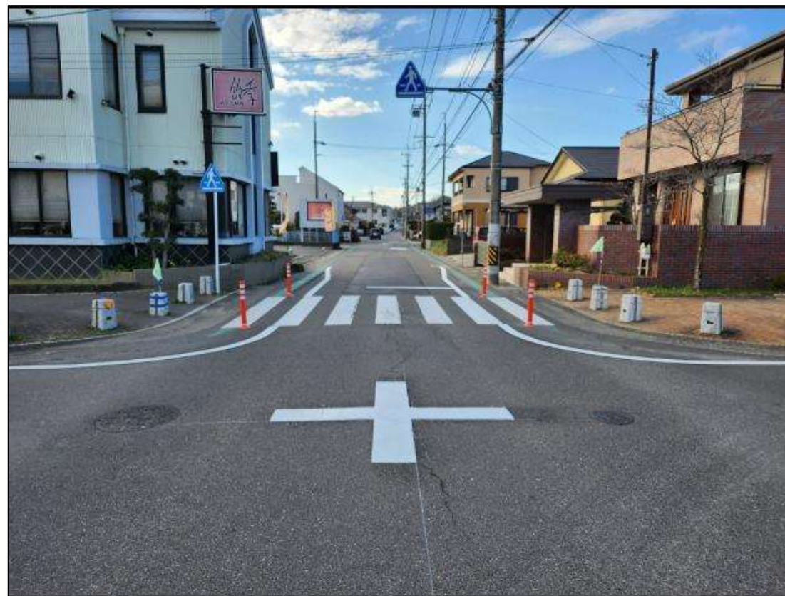
③ 横断歩道のある交差点を外側線とポストコーンで狭さく（市）
