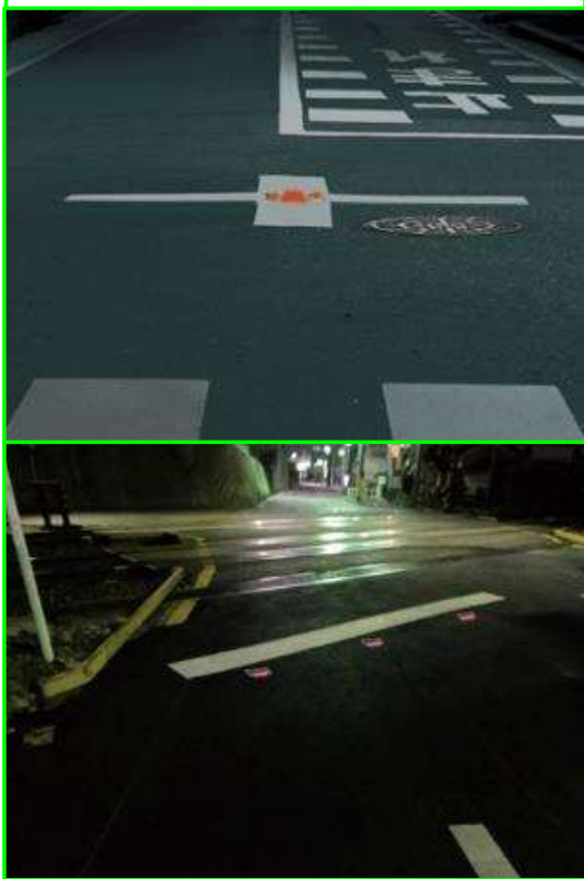
① 道路鉄の更新（市）
