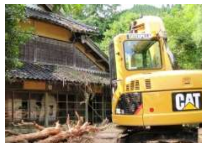
■老朽家屋等解体撤去事例
