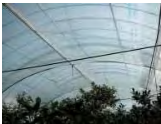
天井部分の空気膜カーテン（左：オオバ、開閉式、右：ハウスミカン・固定式）
