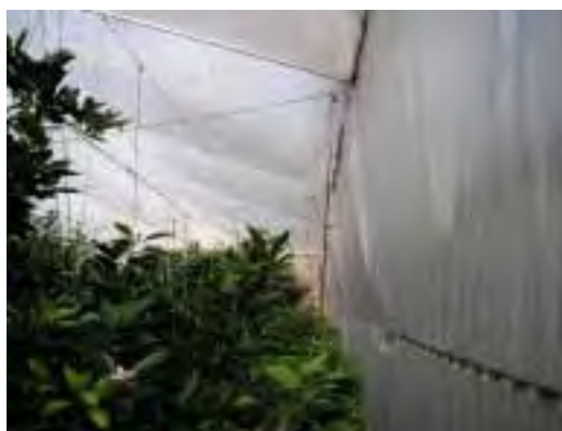
サイド部の空気膜カーテン（左：キク・固定式、右：ハウスミカン・固定式）
