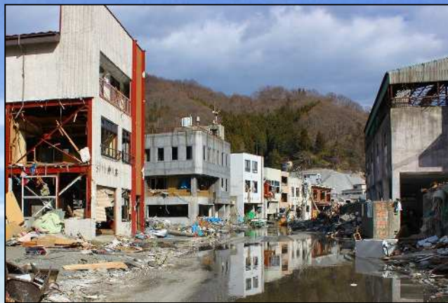
【被災した建築物】
