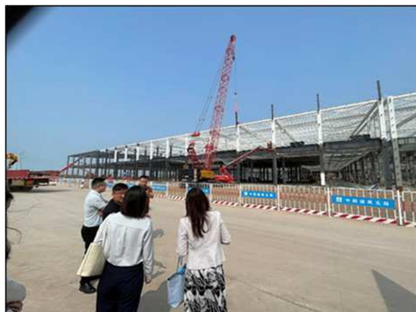
建設中の BYD 電池工場
