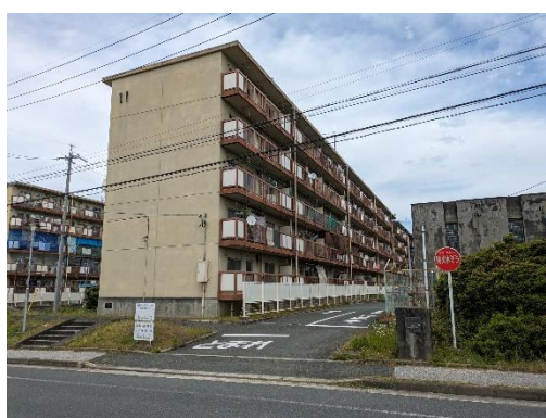
西方より調査対象地 (11号棟、12号棟)
