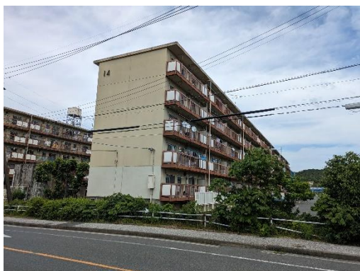
南西方より調査対象地 (14号棟、15号棟)
