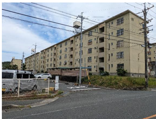
北西方より調査対象地 (11号棟、12号棟)
