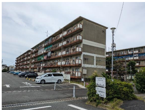
南東方より調査対象地 (14号棟、15号棟)
