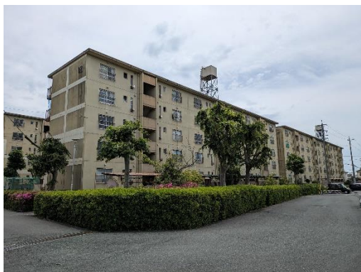
北東方より調査対象地 (11号棟、12号棟)
