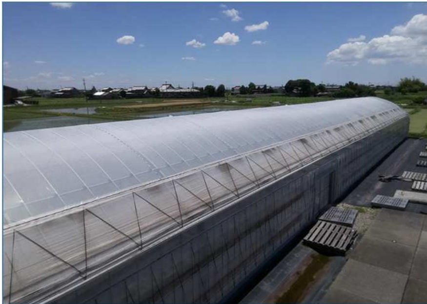
ドローンで遮光剤を塗布したハウス(愛西市)
